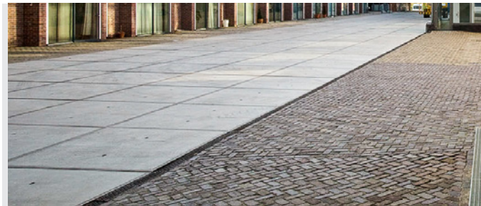
industrieplaten i.c.m. betonklinkers in warme kleurtonen (KWS)
