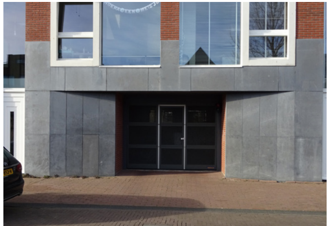
entree parkeergarage in gebouw, natuursteen
