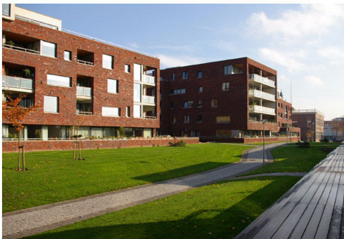
terrassen en dakterrassen met uitzicht en privacy
