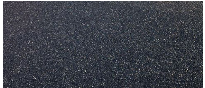
zwart asphalt op hoofdrijbanen (Groenewoud)
