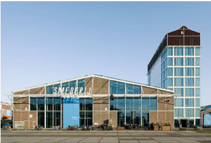
bestaande loodsen met nieuwbouw (NDSM-Smederij A'dam)
