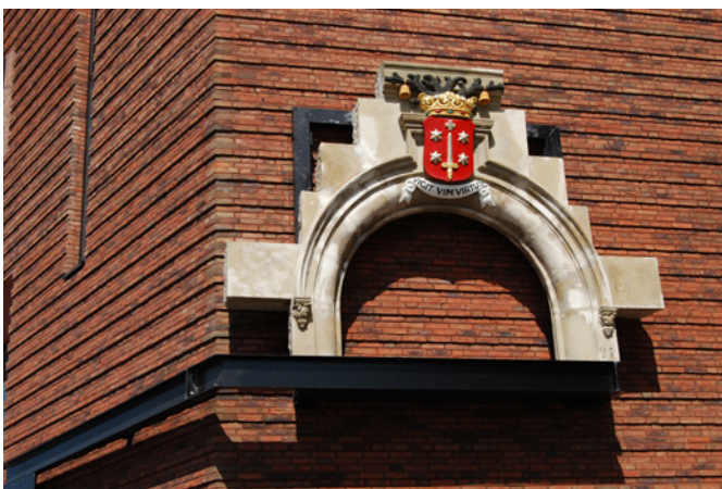
een voorbeeld van hergebruik van elementen van gesloopte gebouwen in nieuwbouw, project Haarlem Raaks
