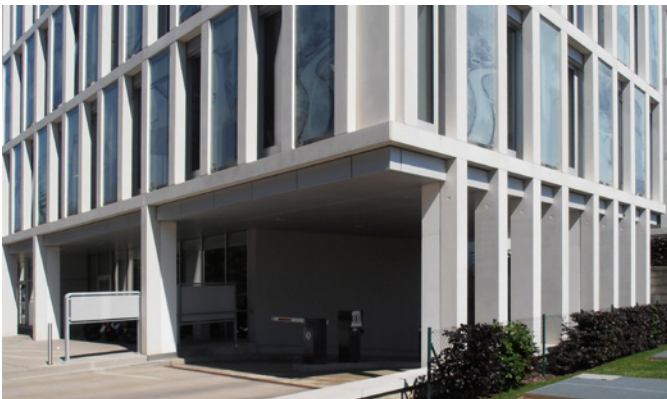
toegang parkeergarage geïntegreerd in het ontwerp
