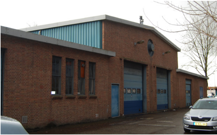
bestaande karakteristieke jaren 50 hallen
