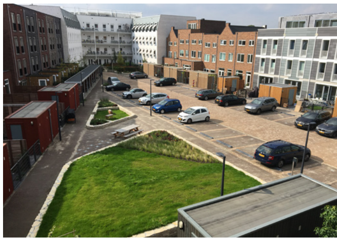
binnenterrein bouwblok met parkeren en groen
