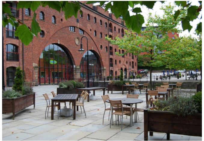
industriële gebouw inspireert voorzieningen
