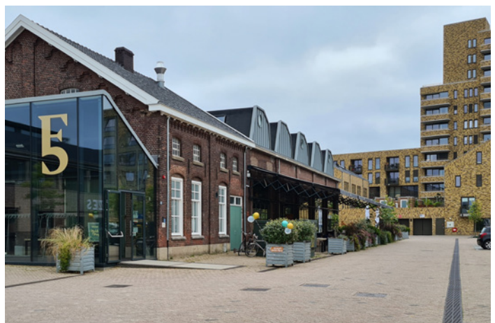
horeca in voormalig kolengasfabriek NRE terrein Eindhoven
