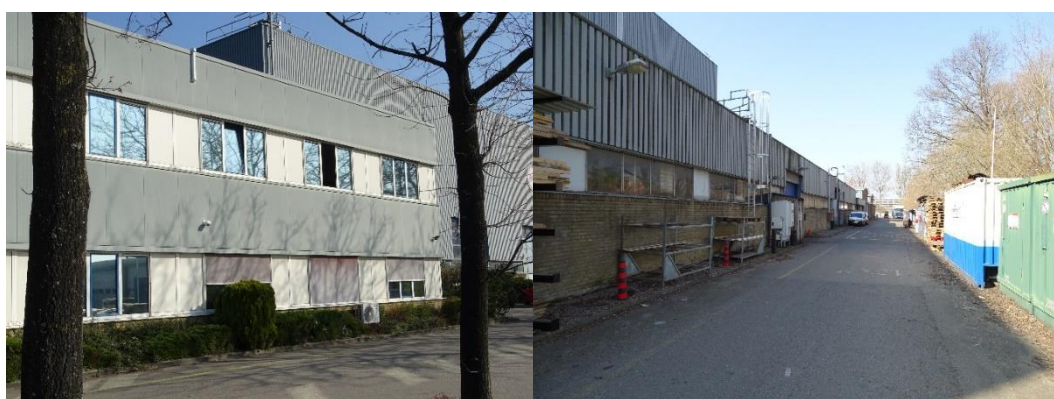
Afbeelding 8, links de muren die volledig uit beplating bestaan en rechts de muur aan de noordkant van het gebouw die door beplating en het ontbreken van open stootvoegen ongeschikt is voor vleermuizen, (foto's Laneco).
