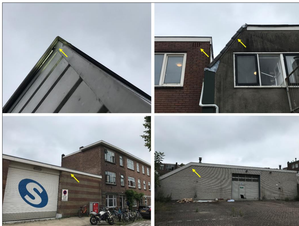
Figuur 1.3 Middels kierende kantpannen, daklijsten en open stootvoegen kunnen vleermuizen toegang krijgen tot binnenruimtes waardoor potentie voor vorengenoemde soorten niet uitgesloten kan worden.
