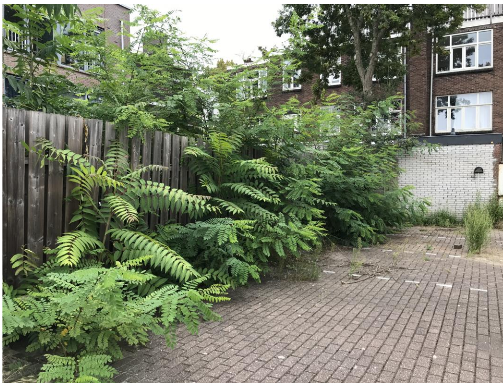
Figuur 4 Op het parkeerterrein aan de achterzijde van de panden is sprake van verruiging en overgroeiing als gevolg van achterstallig onderhoud.
