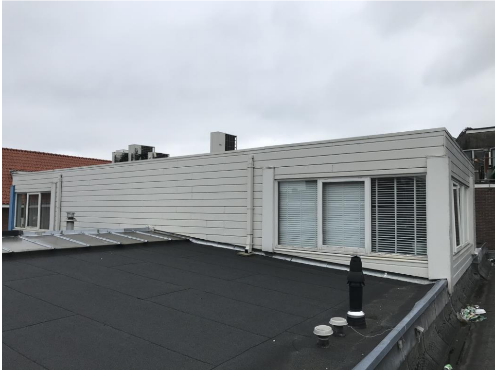
Figuur 5 De bedrijfslocatie (Gansstraat 143) bestaat uit één bouwlaag met uitzondering van de entree daar is sprake van twee bouwlagen.
