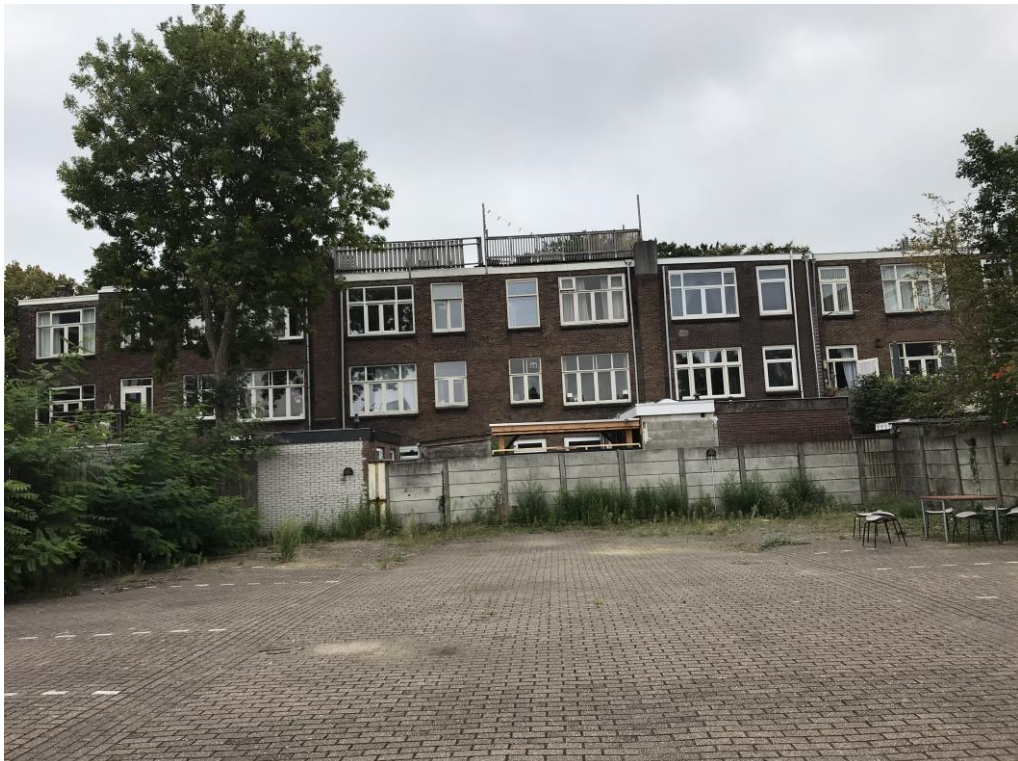
Figuur 6 De achterzijde van het perceel aan de Gansstraat 143 is ingericht als parkeerplaats.
