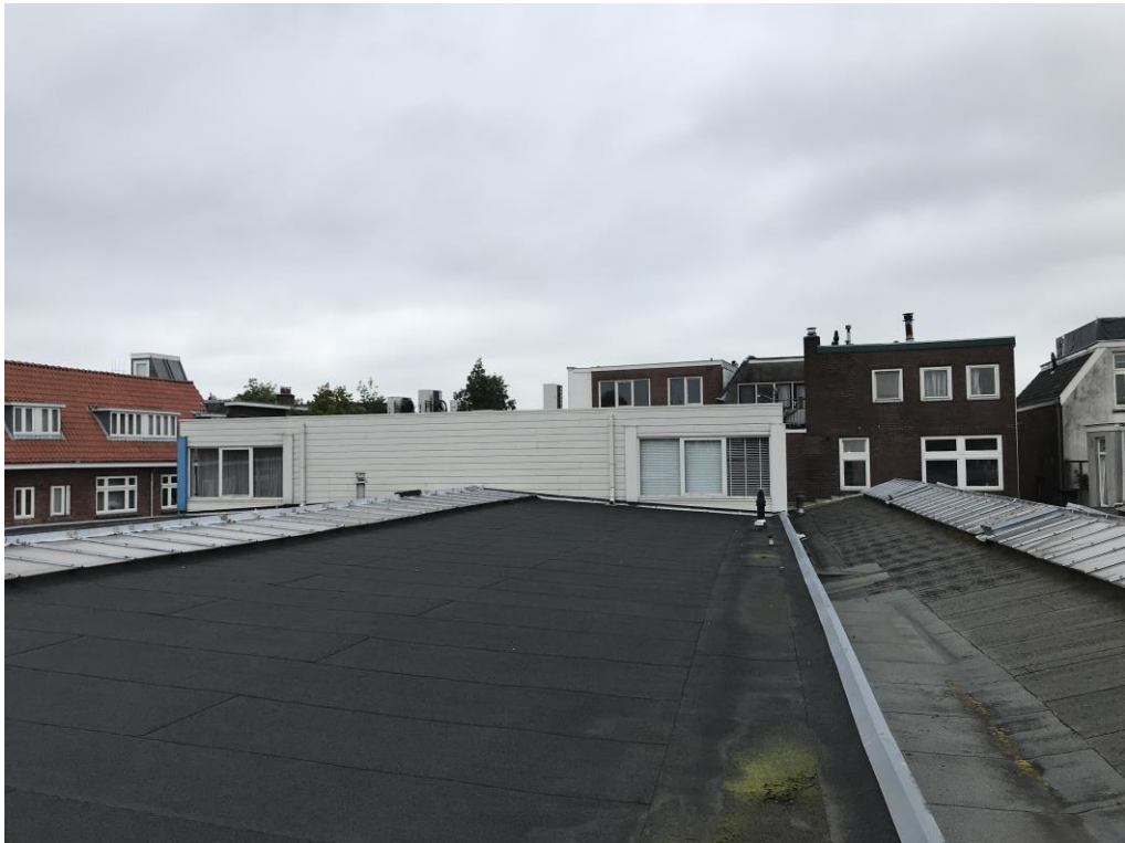
Figuur 4 De bedrijfslocatie (Gansstraat 143) bestaat uit flauwe zadeldaken met bitumineuze dakbedekking en in de nok een lichtkoepel.
