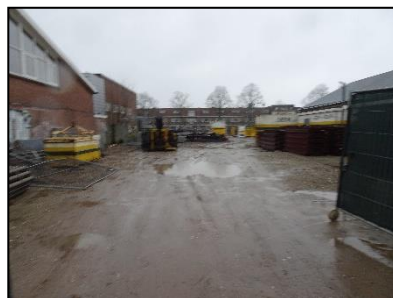
Figuur 7. Overzicht perceel ten zuiden van de loods.
