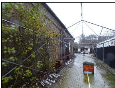
Figuur 6. Pad langs de loods
