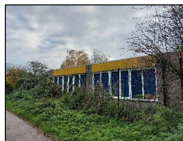
Figuur 2.5. De school direct ten zuiden van de onderzoekslocatie (kijkrichting zuidelijk).
