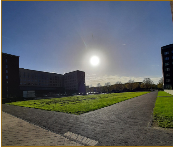
Afb. 1.10: Kavel t3 gezien vanaf de Orteliuslaan.
