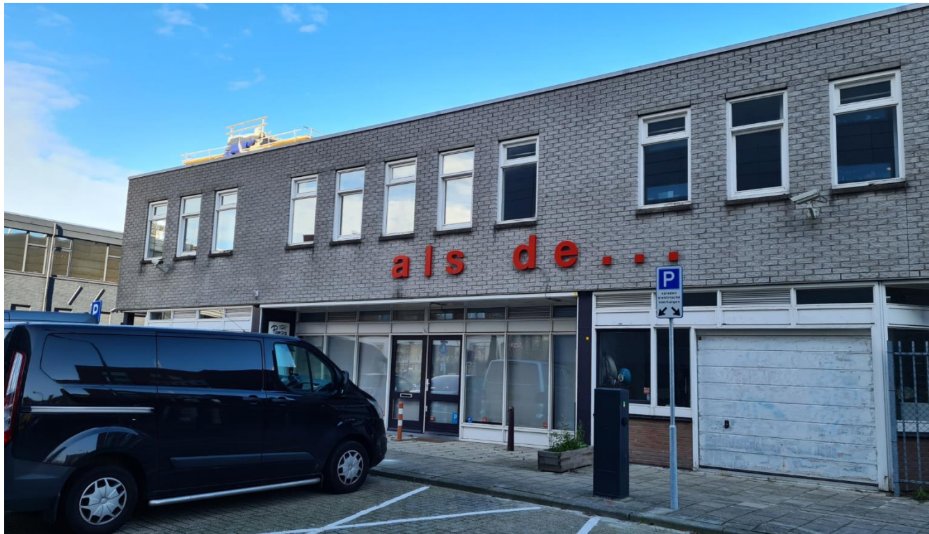
Figuur 4: Zuidzijde Helling 14 gezien vanuit het zuiden
