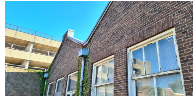
Figuur 6: Voorkant gebouw zuiden
