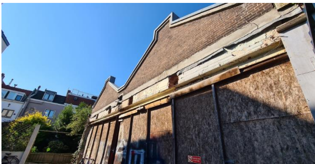
Figuur 7: Achterkant gebouw gezien vanaf noorden
