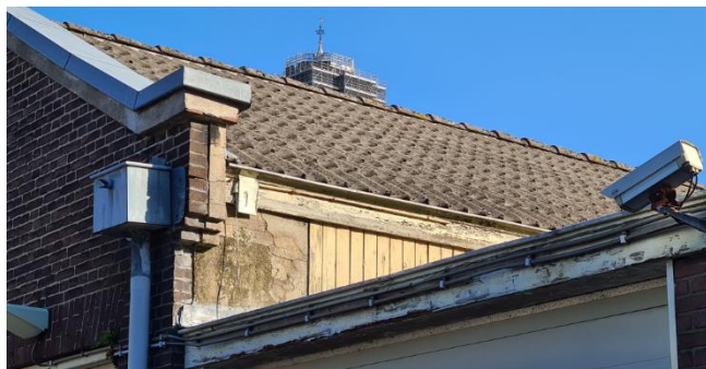
Figuur 8: Detail dak van het gebouw en gedeelte van de uitbouw
