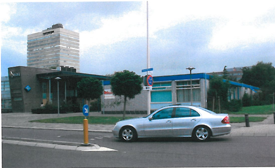
Figuur 5 De bebouwing aan de westzijde van bouwvlek 3
