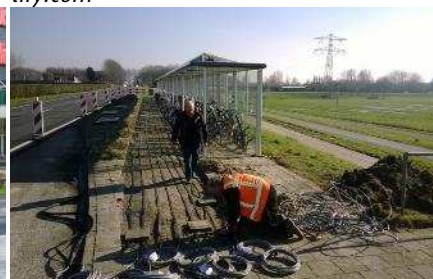
Infraroodstrips tegen gladheid. Bron: dbi.pzh.nl
