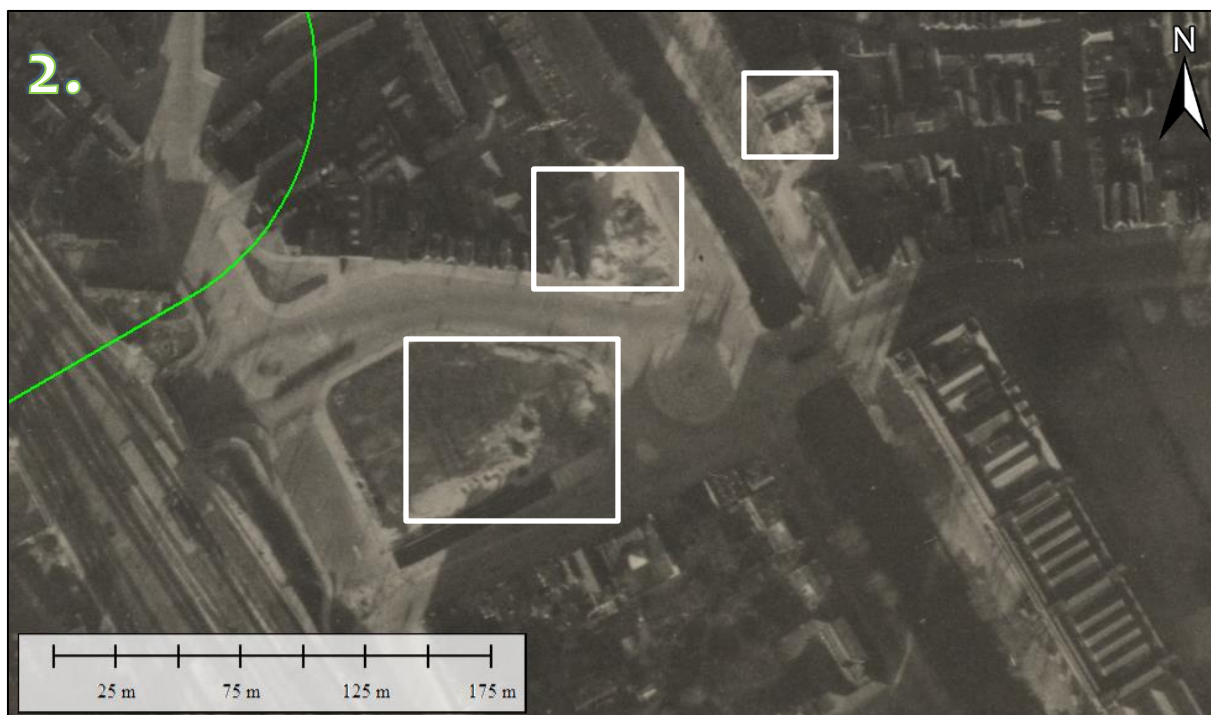
Figuur 37. Een aantal kraters en beschadigde bebouwing op een luchtfoto van 24 december 1944. De schade is afkomstig van het bombardement op 13 oktober 1944.
