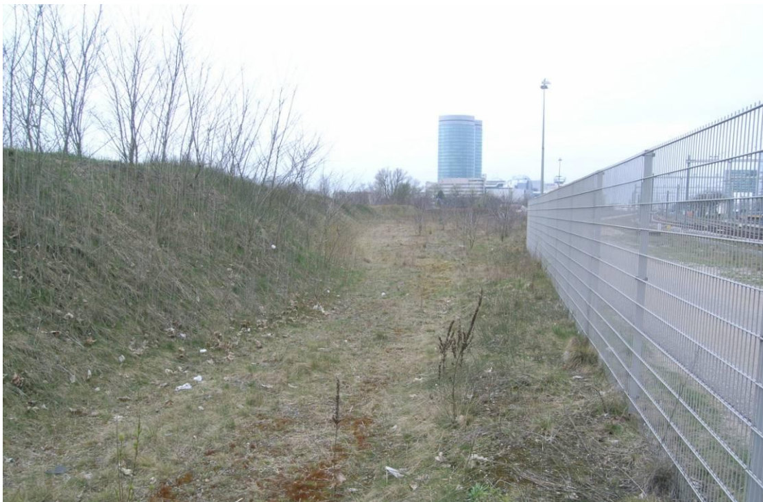
Figuur 4 Terrein langs het spoor t.h.v. aardewal in noordwestelijke richting
