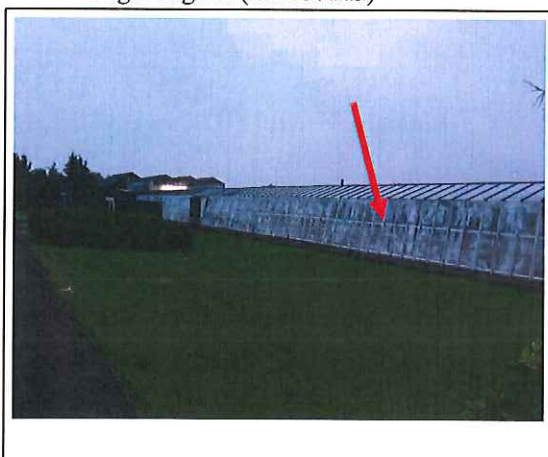
Foto 5: buitenzijde "kas 1955" met asbesthoudende beglazingskit (item 3; M3)
