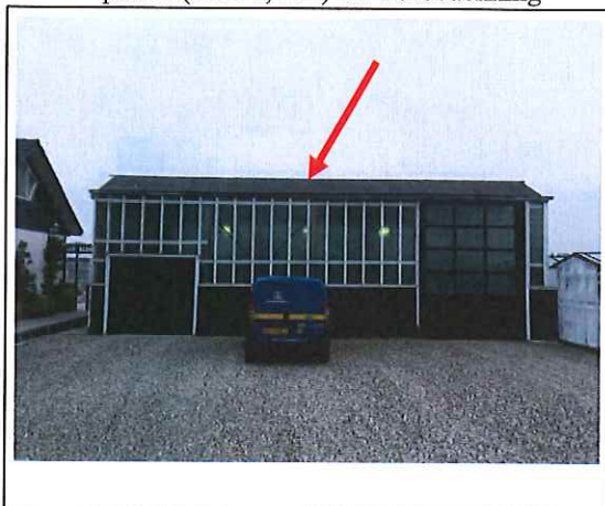
Foto 3: schuur met daarop asbesthoudende golfplaten (item 2; M2) als dakbedekking
