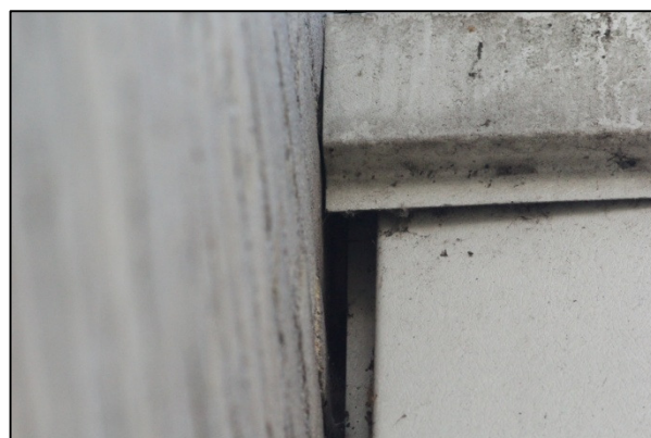
Foto 4: kieren/spleten aansluiting te slopen gebouw Schönberglaan 8
