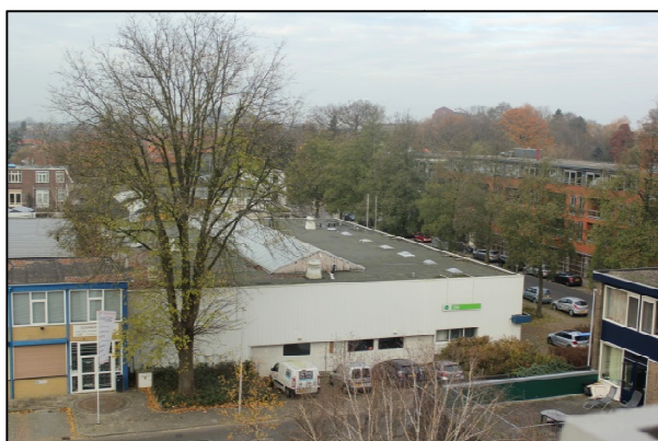
Foto 3: bovenzijde te slopen gebouw
