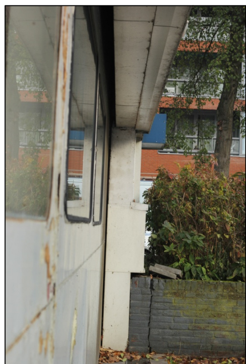
Foto 5: kieren langs de roldeuren van het gebouw, soms ook ruimte tot de gehele bovenzijde
