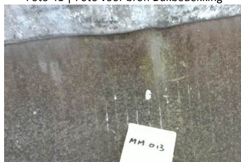
Foto 43 | Foto voor bron Dakbedekking
