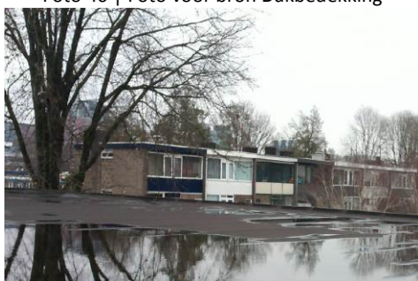
Foto 42 | Foto voor bron Dakbedekking
