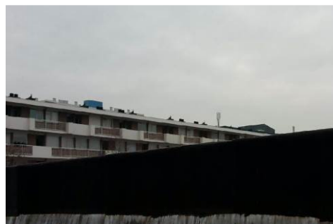
Foto 41 | Foto voor bron Dakbedekking
