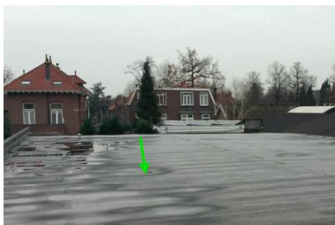
Foto 40 | Foto voor bron Dakbedekking
