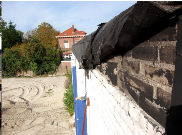
b) zijgevel (zuid-west) met bitumen
