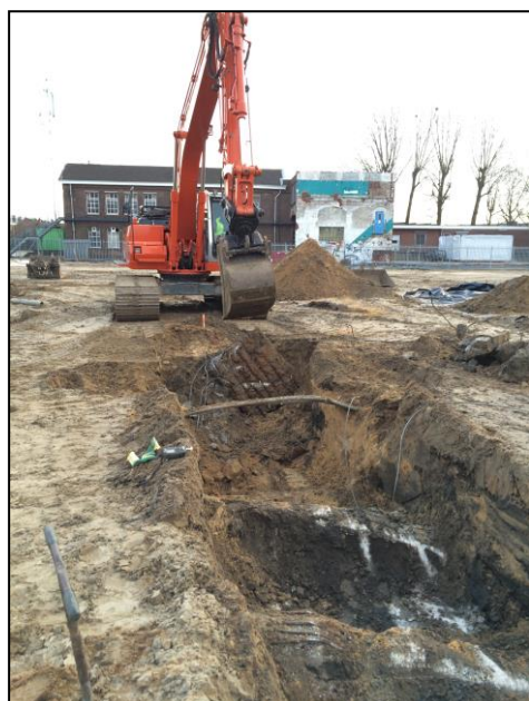
Figuur 7: De aanleg van proefsleuf 5, met duidelijk zichtbaar de grote brokken bouwpuin
