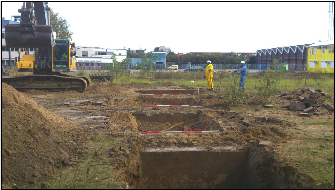
Figuur 5: Aanleg van proefsleuf 1 tijdens de eerste fase van de sanering, in oktober 2014. Ter hoogte van de jalons zijn drie opeenvolgende smeerputten waar te nemen.
