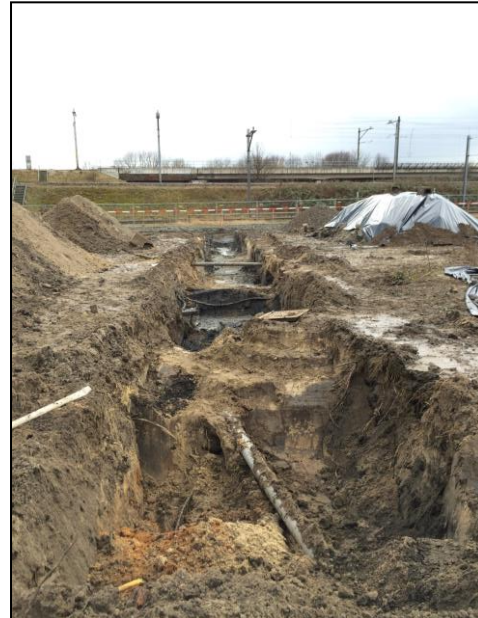
Figuur 6: De aanleg van proefsleuf 6, en het uiteindelijk aangelegde 'vlak'. Duidelijk zichtbaar zijn de vele verstoringen door kabels en leidingen.
