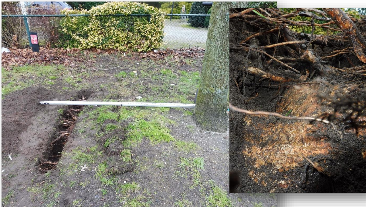
Foto 22: locatie proefsleuf boom 14 Inzet: zijaanzicht proefsleuf boom 14
