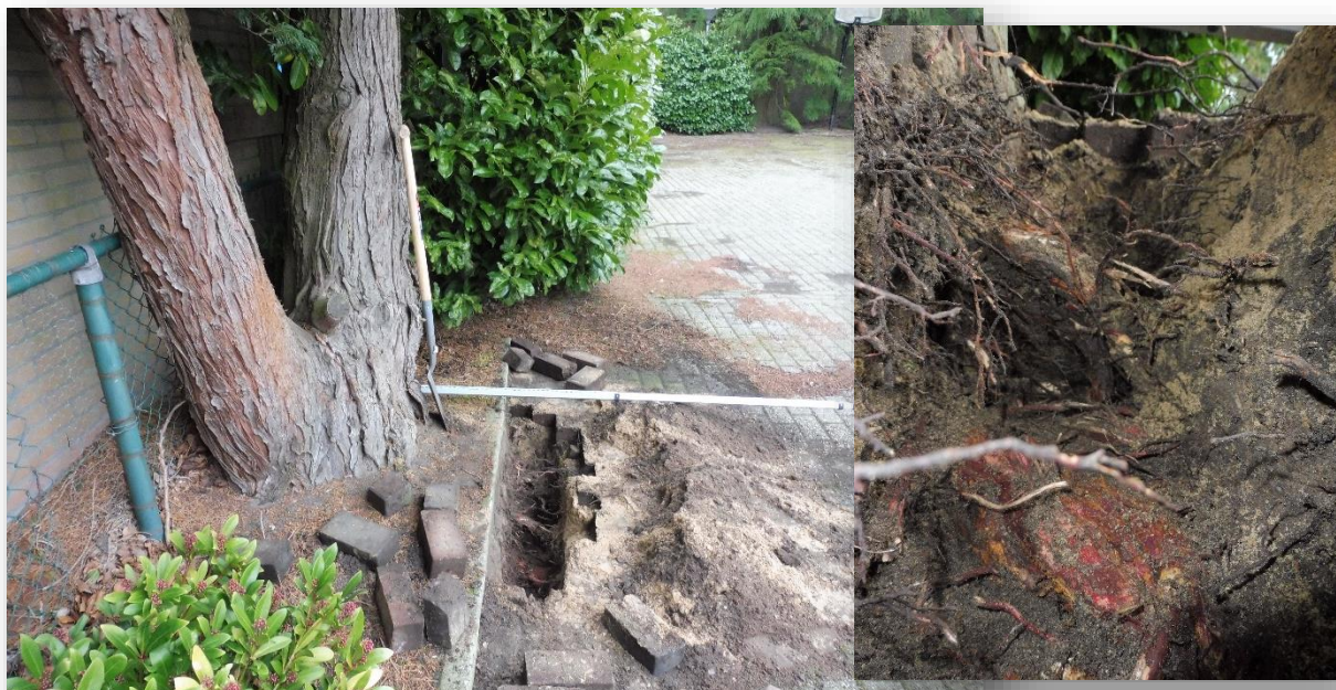
Foto 24: locatie proefsleuf boom 17 Inzet: zijaanzicht proefsleuf boom 17
