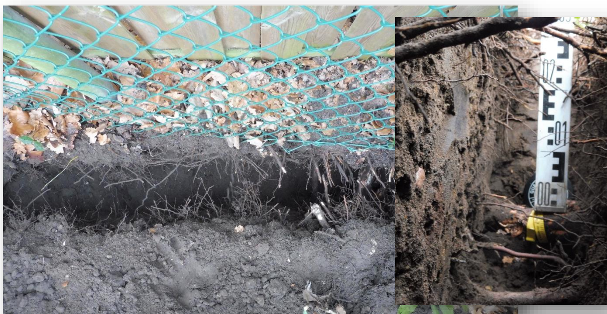
Foto 25: locatie proefsleuf boom 34a Inzet: zijaanzicht proefsleuf boom 34a
