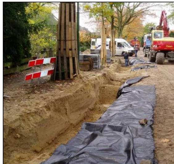
Foto 18: aanleggen strook Bomengranulaat
