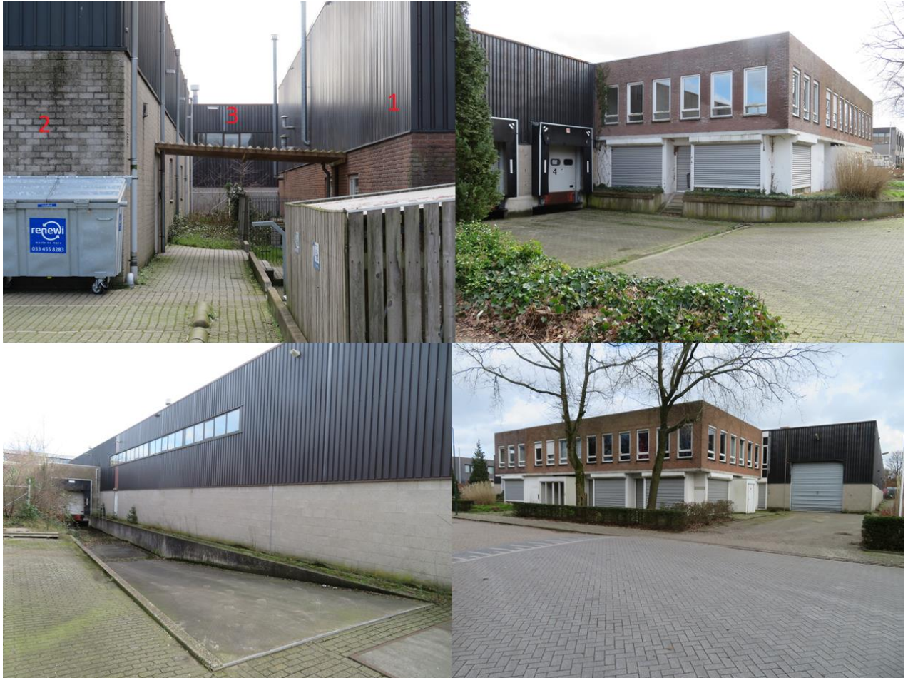
Foto-impressie opstal 3. De foto linksboven geeft aan hoe de gebouwen ten opzichte van elkaar zijn gelegen.
