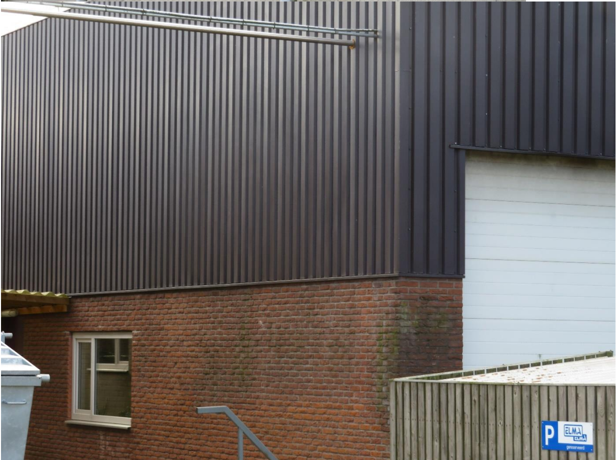
Naadloze aansluiting plaatstaal op bakstenen bij alle gebouwen.
