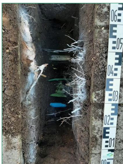
Afbeelding 3.8 Aangetroffen kabels en leidingen in een profielsleuf
