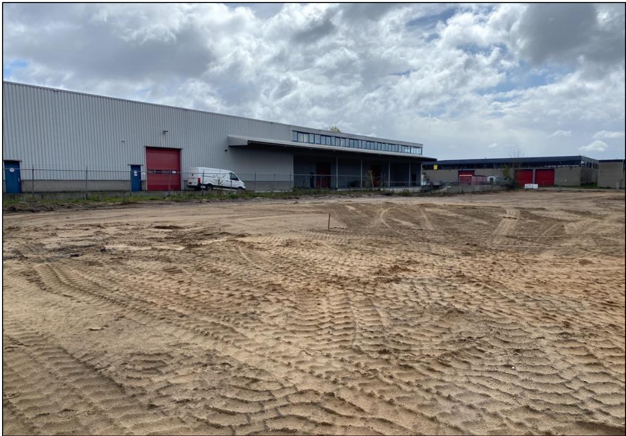
Figuur 12. De huidige situatie binnen het projectgebied. De bebouwing is gesloopt.
