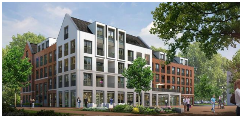
Afb. 62 Den Bergh: verbijzondering op de kop en verticale elementen in kap
