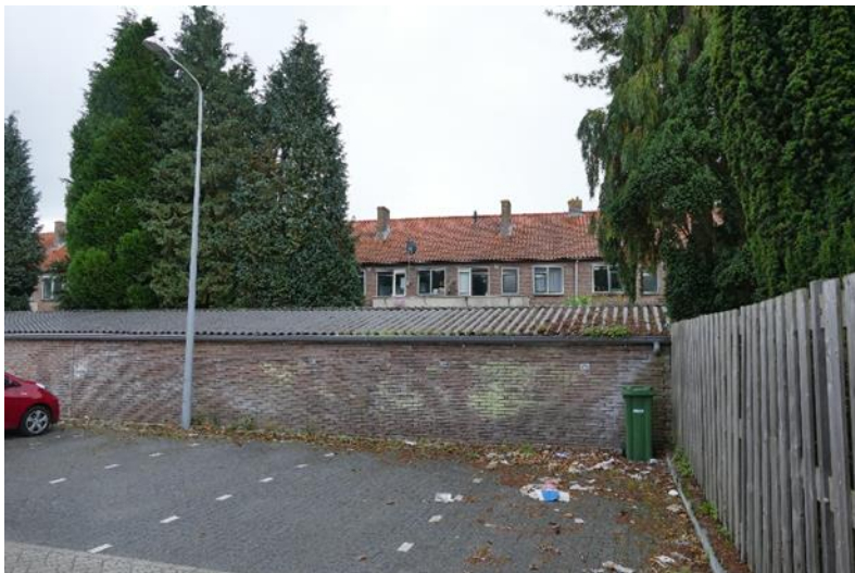
Afb. 28 Achterzijde bergingen gezien vanaf parkeerterrein Rademakerstraat
