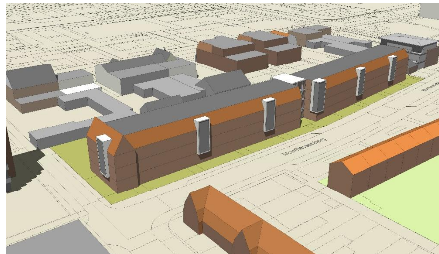
Afb. 42 Verbijzondering in de gevel: verticale accenten met andere materialisering en verbijzondering bij entreepartij
