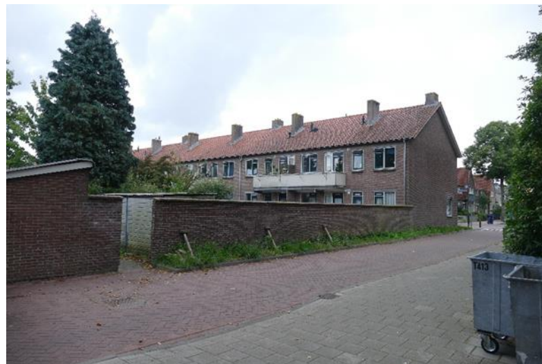
Afb. 30 Diepe achtertuinen afgescheiden door (ondersteunde) muur op kop
