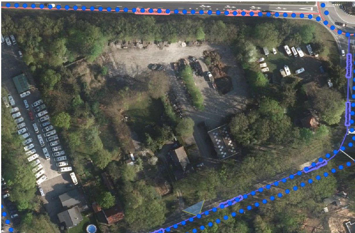
figuur 1: luchtfoto van het gebied, bron: google maps
