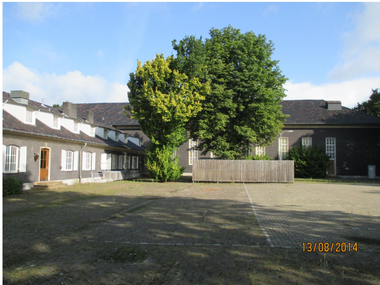
Afbeelding 5; Foto van de dwarsvleugel aan de achterzijde (links) met het hoofdgebouw op de achtergrond.
