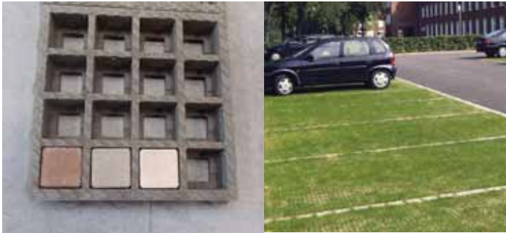
Parkeervakken hoofdentree: Kunststof roostertegels met gras pockets en klinker ter plaatsen van vakbegrenzing
