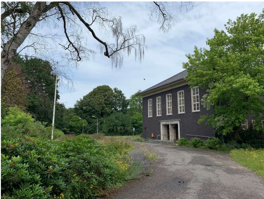
Foto – huidige situatie Officierscasino
