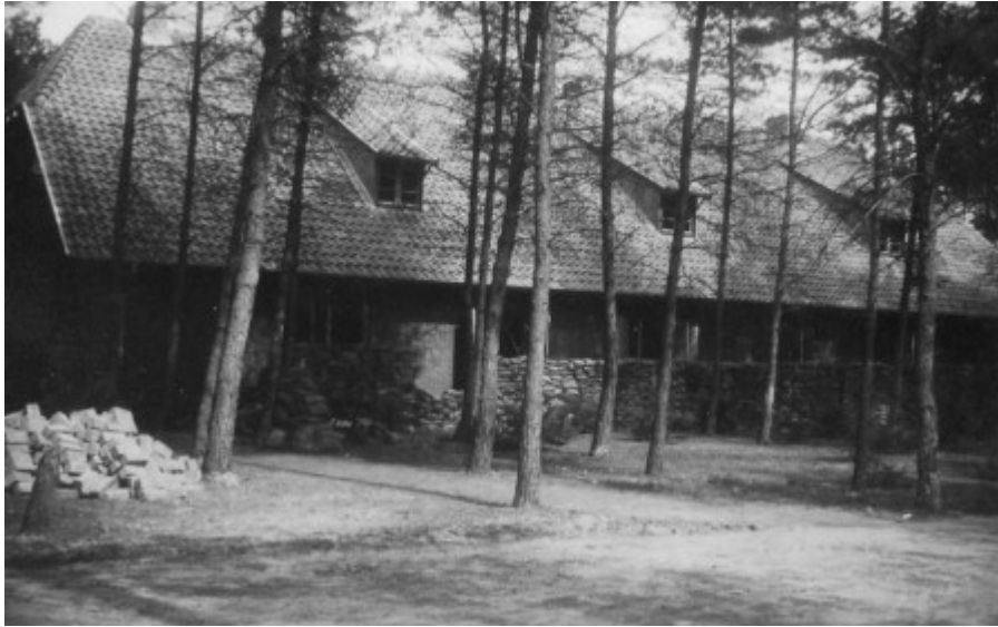
Foto – gebouw op één van de Soesterbergse Waldlagers in Heimatstil [bron: Stichting Legerplaats Soesterberg]
