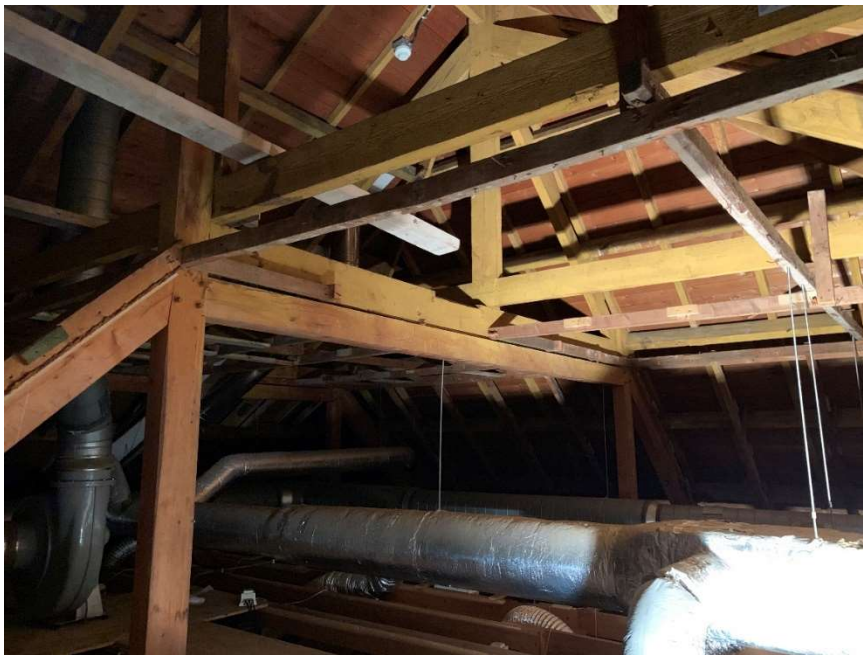
Foto – bestaande spantconstructie kop zijvleugel
