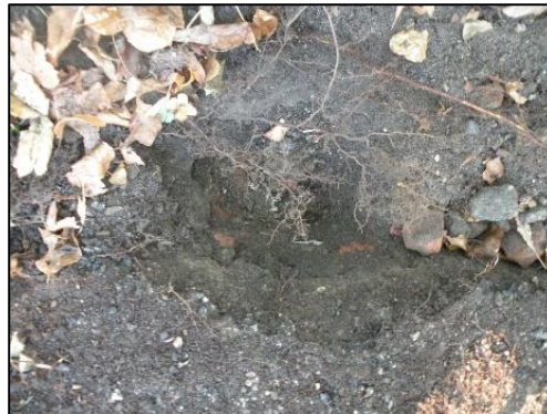
foto 4: bestaande puin fundering
