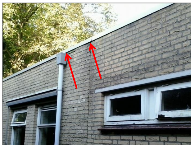
Foto 8 | Voorbeelden van openingen die toegang tot de spouwmuur bieden. Hier aan de westkant van het lange bedrijfspand.
