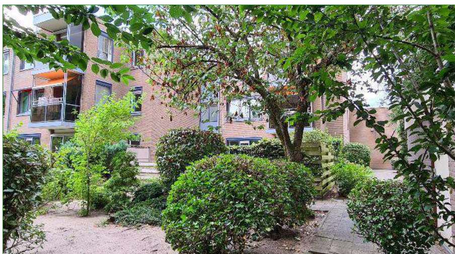
Overzicht van een deel van het parkeerterrein(boven) en de gevelmuren van het appartementencomplex waar de beoogde nieuwbouw aan gekoppeld zal worden (onder).
