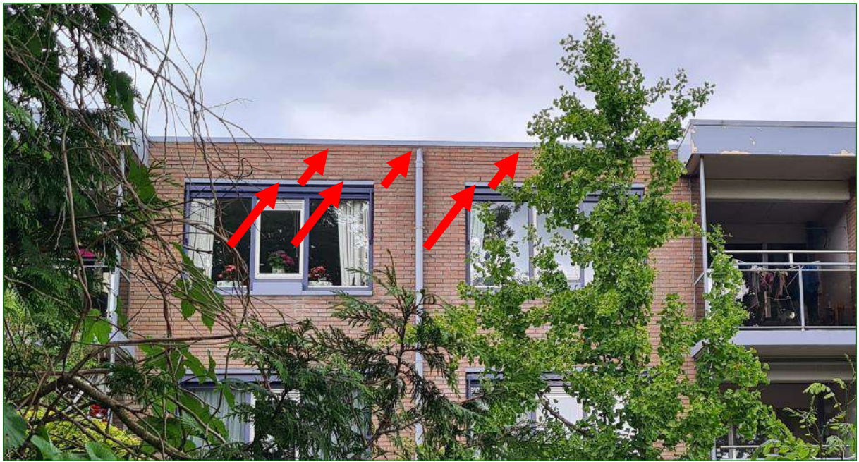
Impressie van enkele spouwgaten en spleten in de gevels van de aangrenzende bebouwing (rode pijlen) waar het nieuwe complex tegen aan gebouwd wordt. Deze openingen geven mogelijk toegang tot voor vleermuizen geschikte achterliggende ruimtes.
