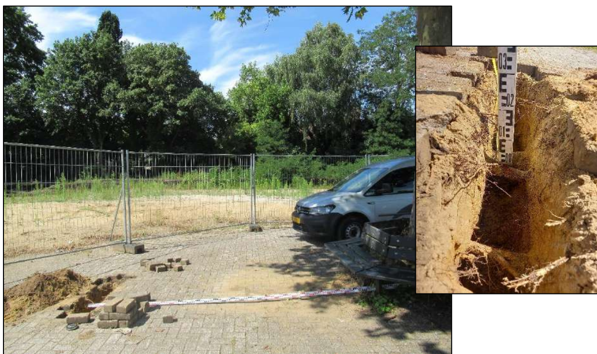
Foto 11: proefsleuf 4 meter uit hart stamvoet boom 1 Inzet: zij aanzicht proefsleuf
