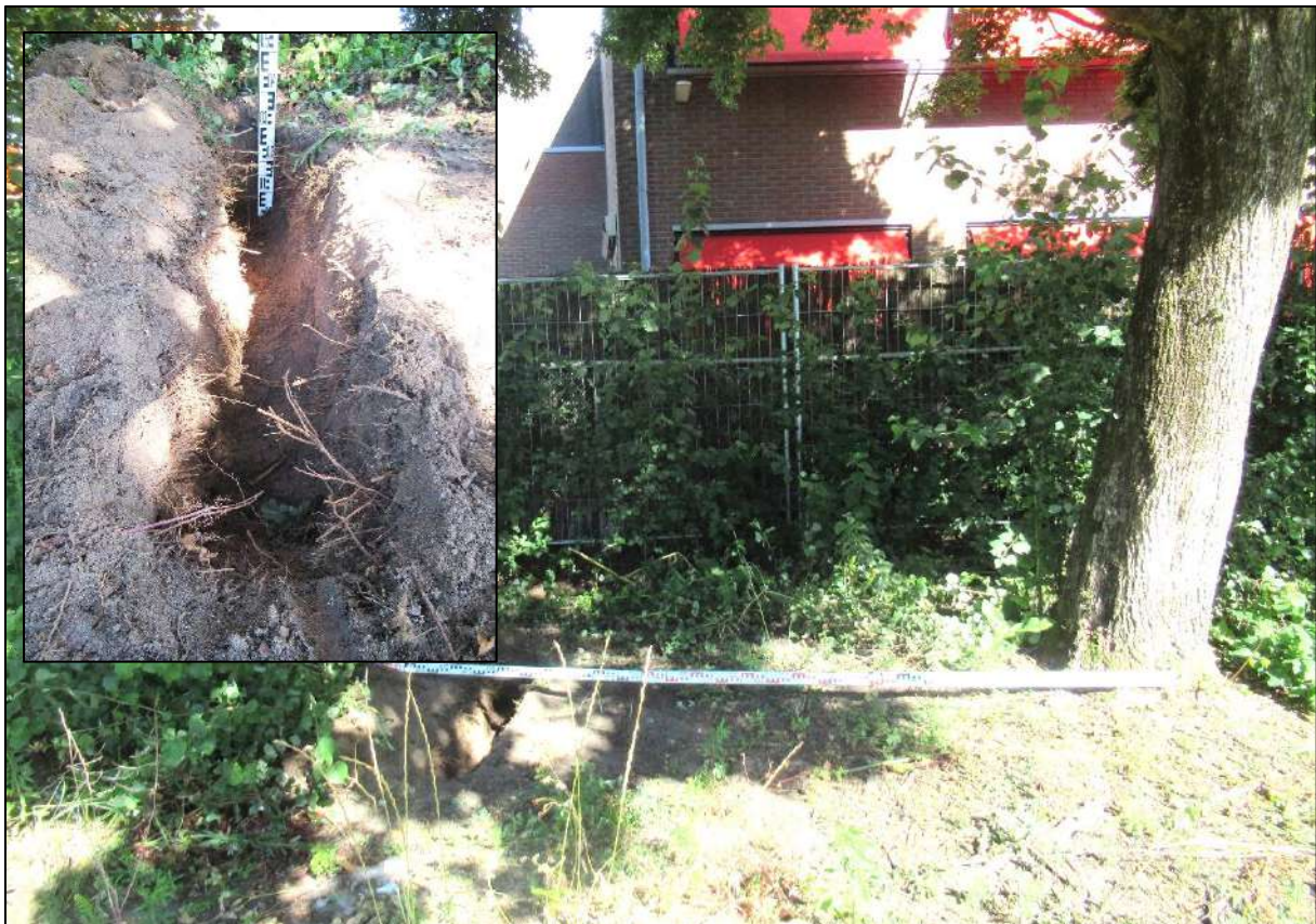
Foto 21: proefsleuf nabij boom 33 Inzet: zijaanzicht proefsleuf
