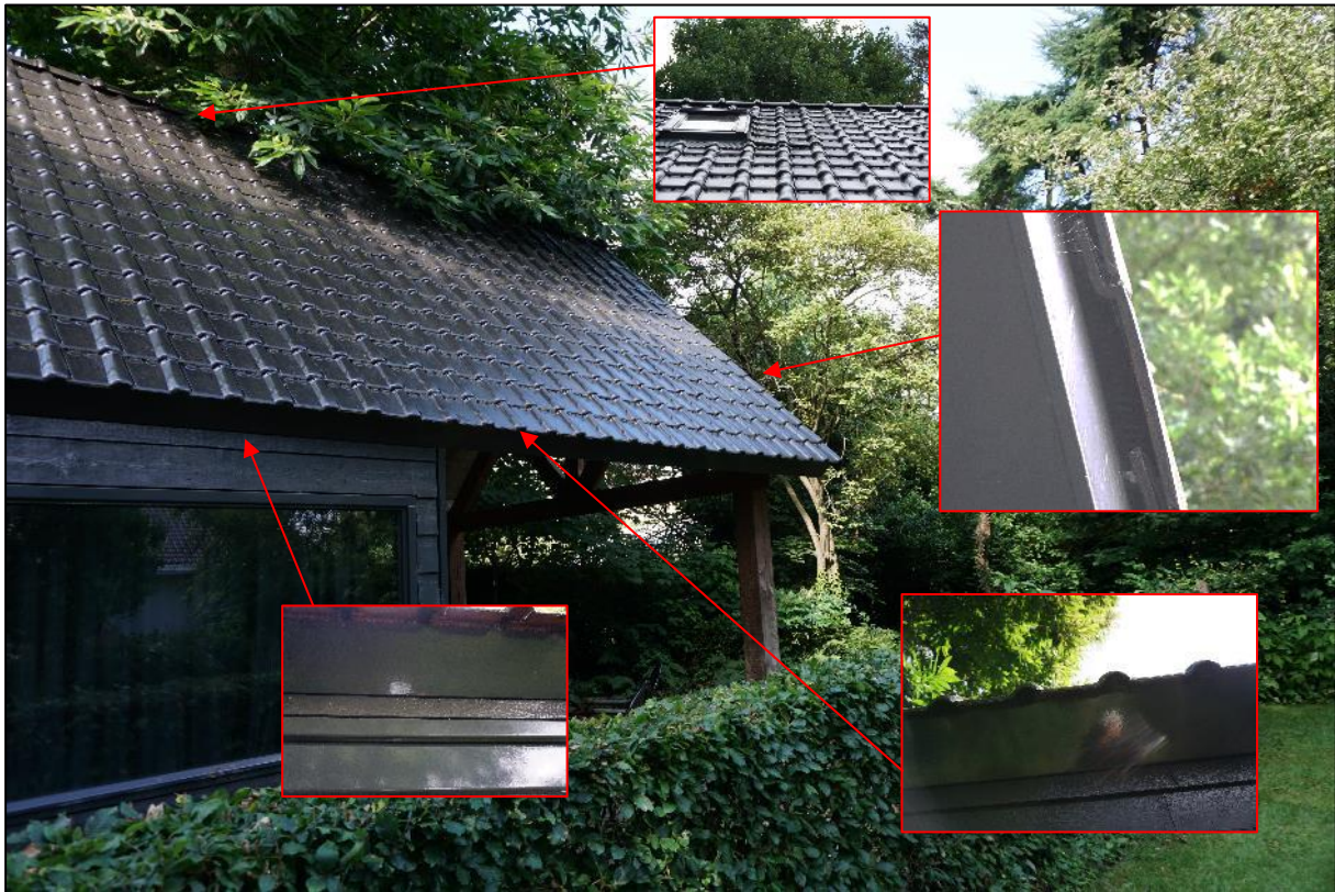
Figuur 4.1 Het aanwezige vakantiehuisje is hermetisch afgesloten.
