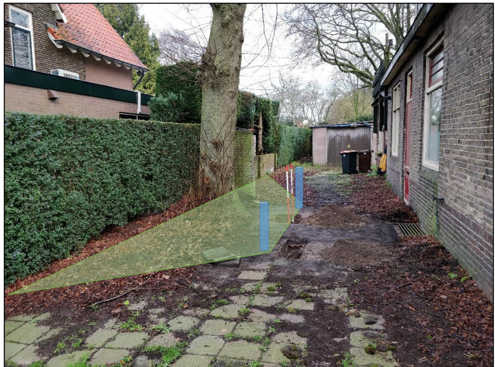
Afbeelding 12. Af te schermen vrije zone waarin belangrijke wortels van de boom worden beschermd door afzetting (groen), aangegeven door jalonstokken
