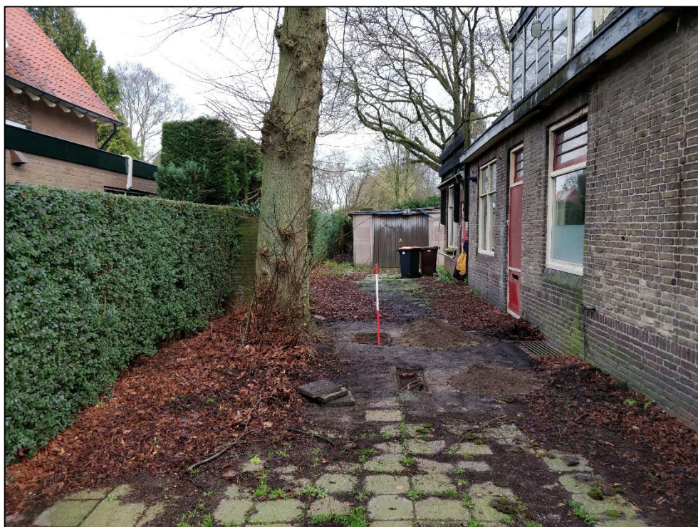
Afbeelding 4. Overzicht profielsleuven en grondboring
