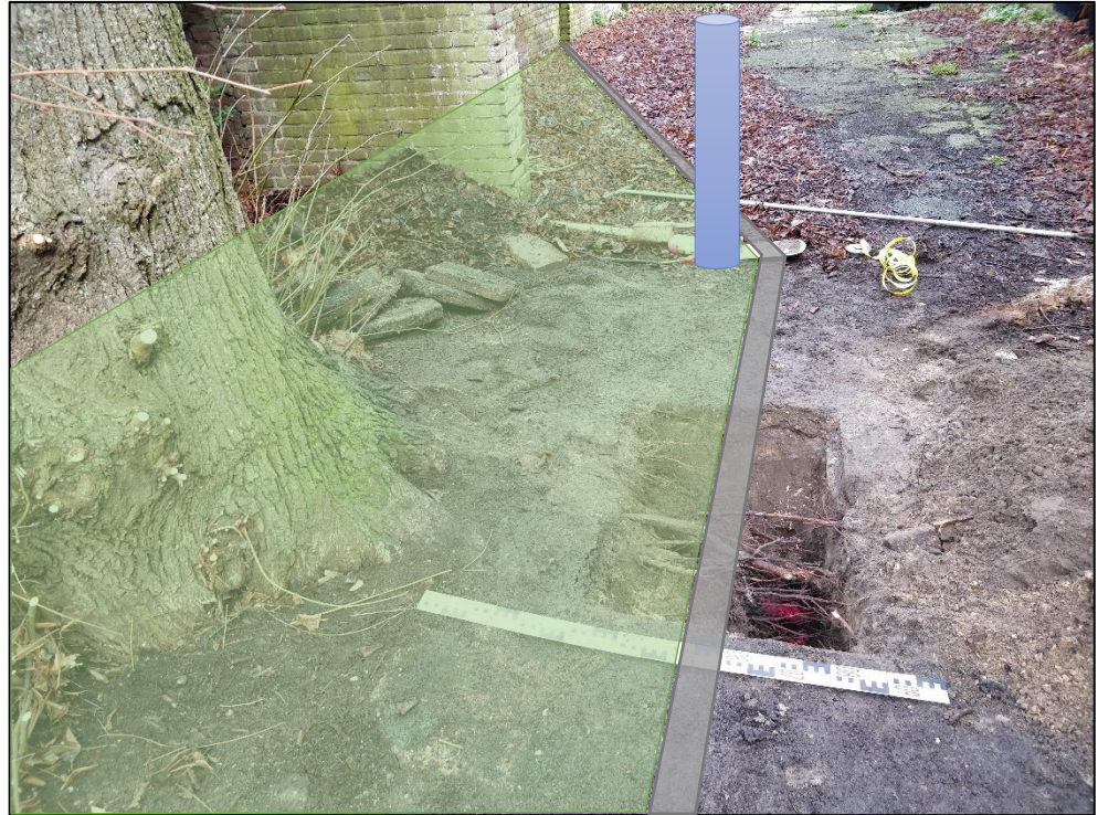
Afbeelding 11. Af te schermen vrije zone (groen) met opsluitband (grijs) en beschermingspaal (blauw)
