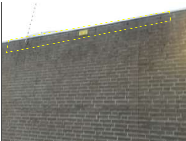
Open stootvoegen in de buitengevel van het voormalig politiebureau. Deze worden in het gele kader aangeduid.
