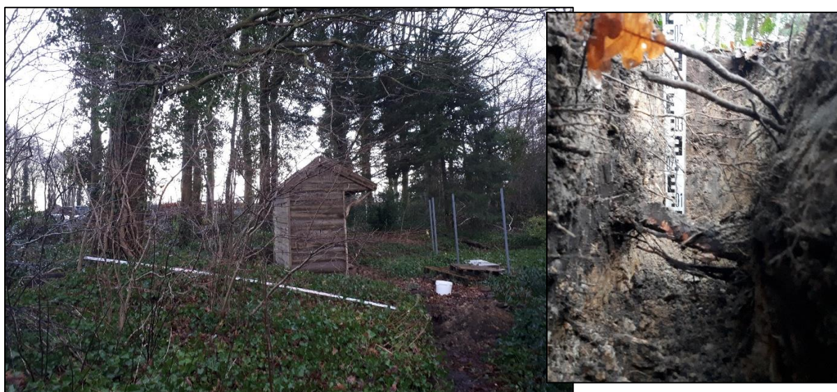
Foto 15: locatie proefsleuf zuidwestzijde boom 48 Inzet: zijaanzicht proefsleuf
