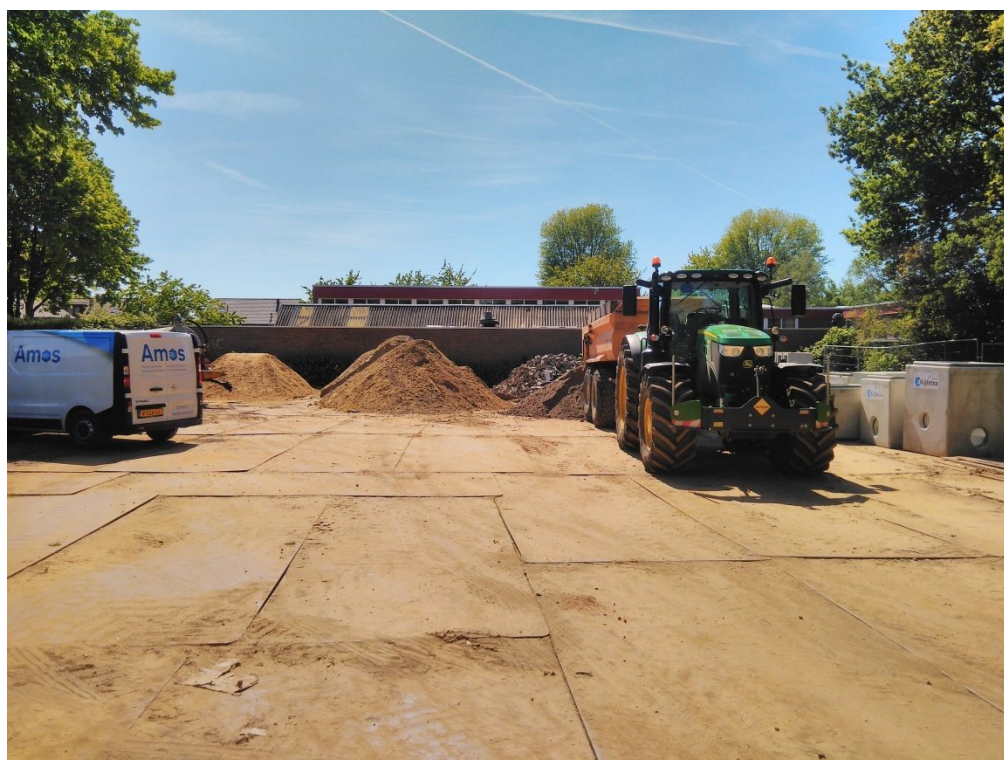
Foto 2: overzicht, perceel 2101, opslag materiaal i.v.m. rioleringswerkzaamheden Molenstraat
