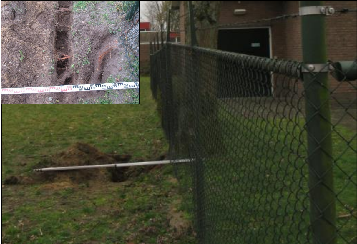
Foto 15: Locatie proefsleuf boom 3 Inzet: beeld proefsleuf
