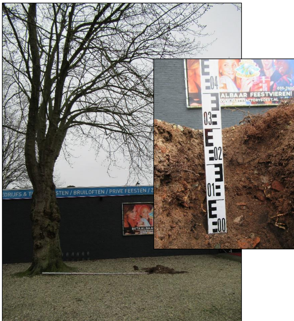
Foto 12: Locatie proefsleuf boom 1 Inzet: zijaanzicht proefsleuf
