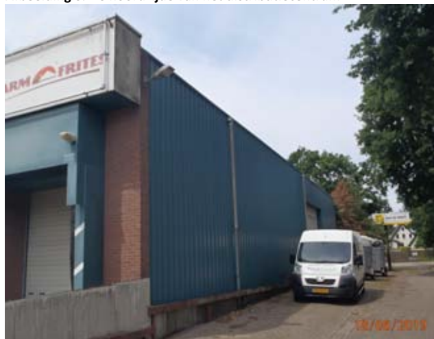
Afbeelding 8. De noordzijde van het distributiecentrum
