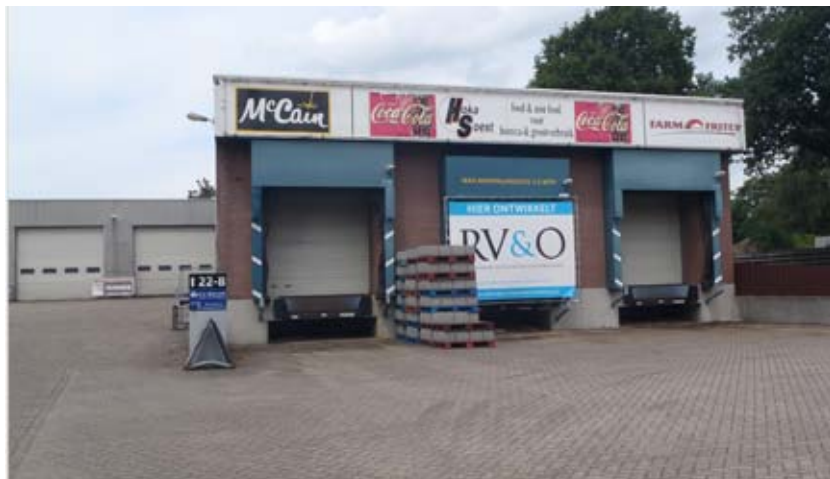
Afbeelding 7: Het te slopen distributiecentrum
