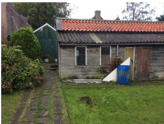
Figuur 7: Overzichtsfoto bebouwing
