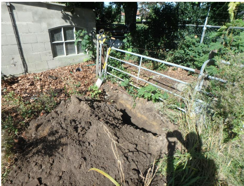
foto 7. Profielsleuf bij boom nr. 36
