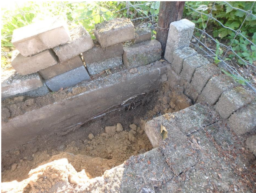
foto 3. Profielsleuf bij boom nr. 3 in de hoek van de klinkerverharding
