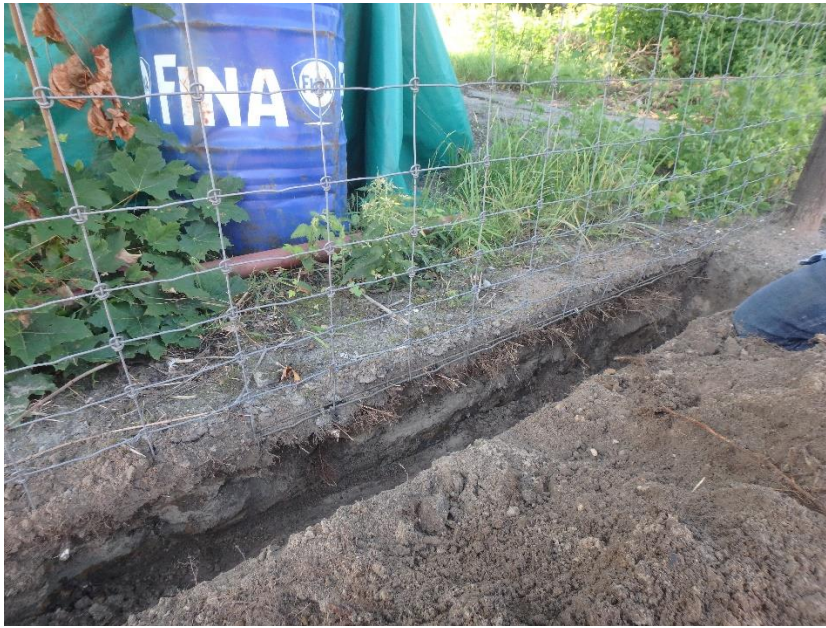
foto 4. Profielsleuf bij boom nr. 9 aan de rand van de betonverharding
