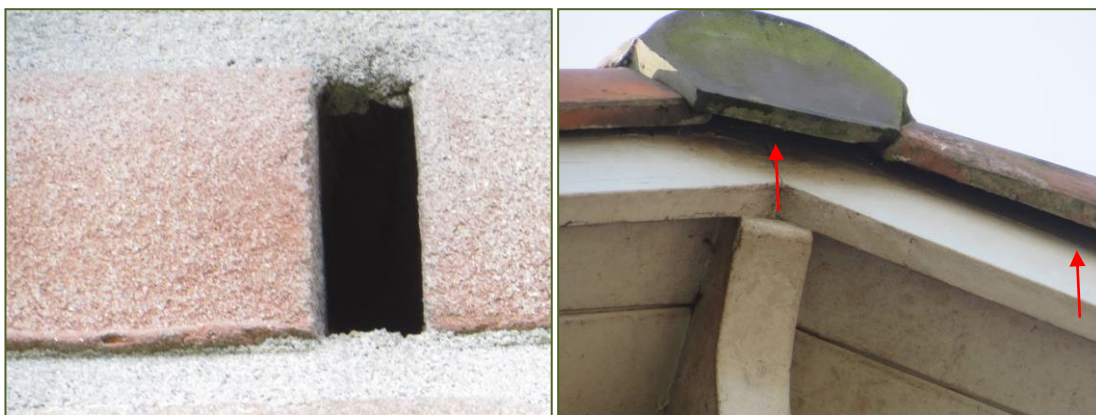
Foto's: Open stootvoeg en openingen bij nokpan.
