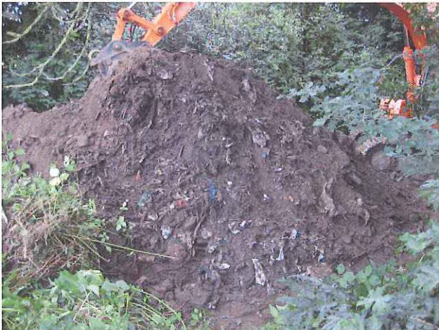
Fotonummer: 03 Omschrijving: Ontgraven stortmateriaal
