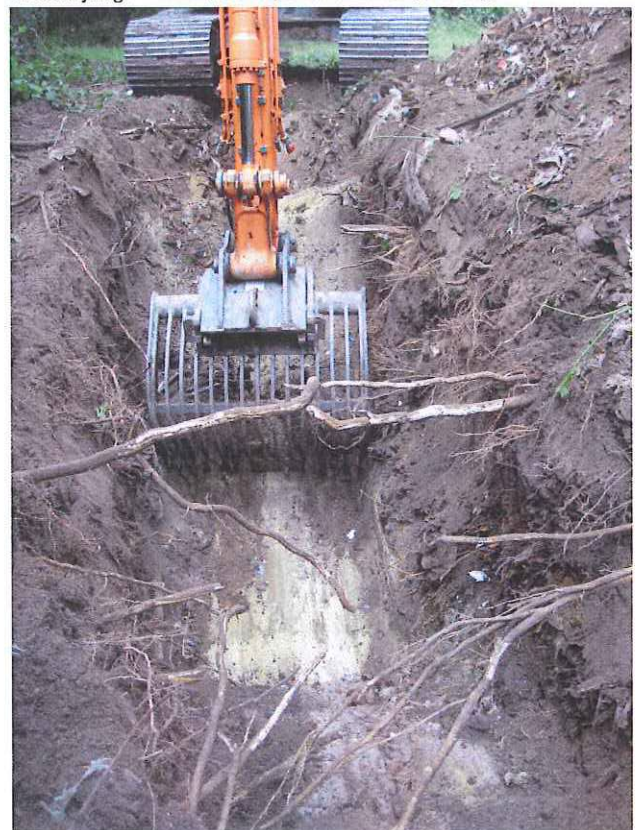
Fotonummer: 08 Omschrijving: Sleuf 1, einde stort (gele ondergrond)
