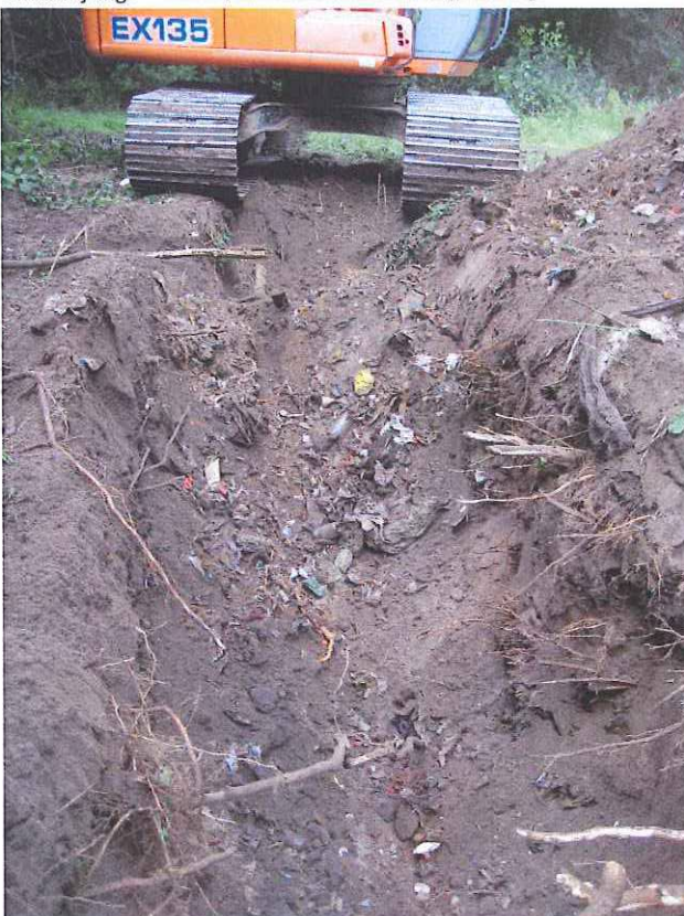
Fotonummer: 07 Omschrijving: Sleuf 1, einde stort
