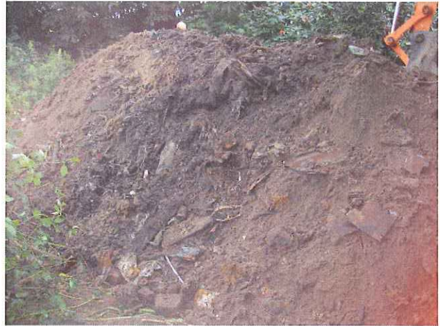
Fotonummer: 02 Omschrijving: Ontgraven stortmateriaal
