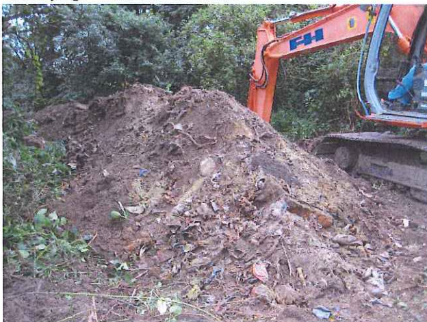
Fotonummer: 05 Omschrijving: Ontgraven stortmateriaal
