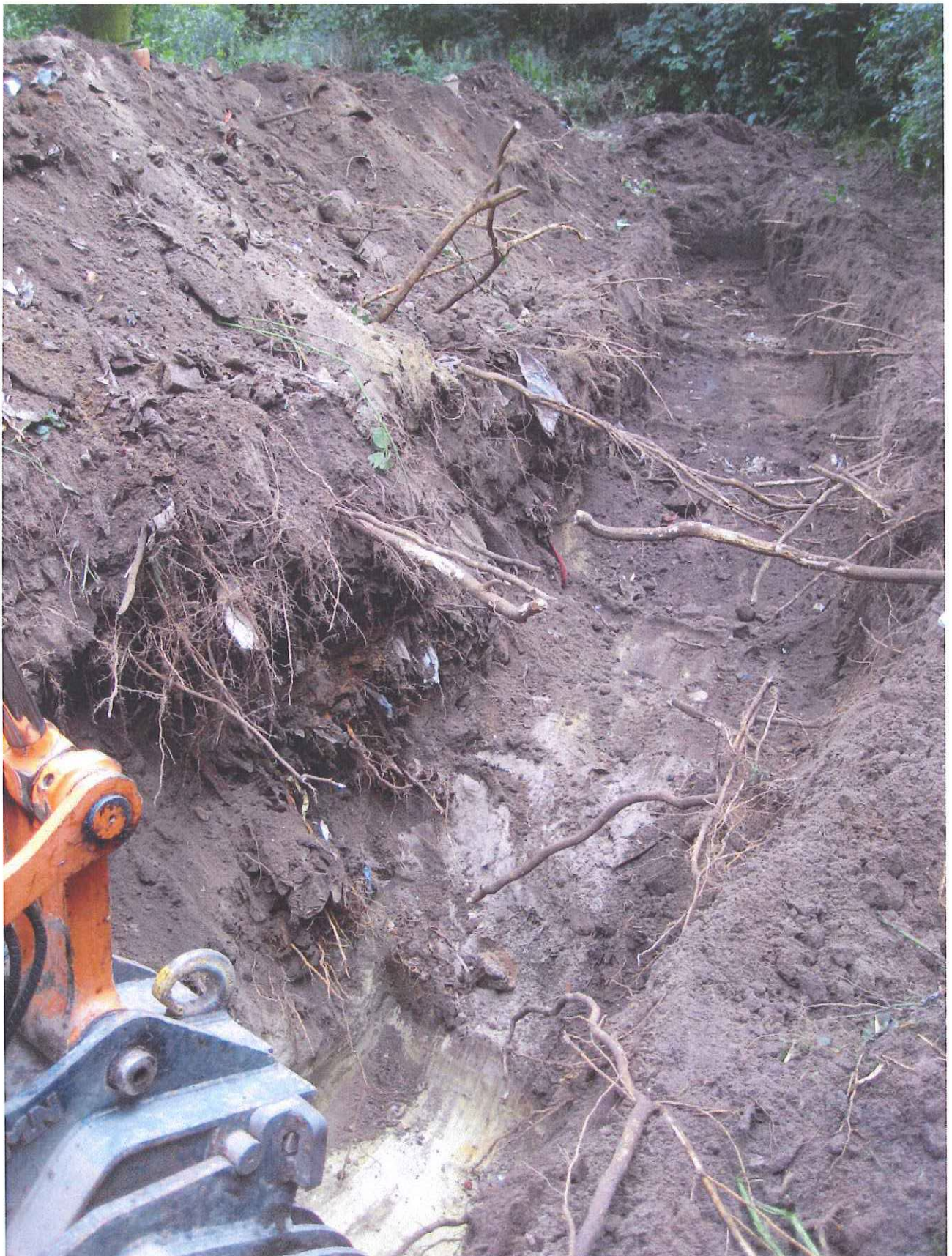
Fotonummer: 09 Omschrijving: Overzicht ligging sleuf 1
