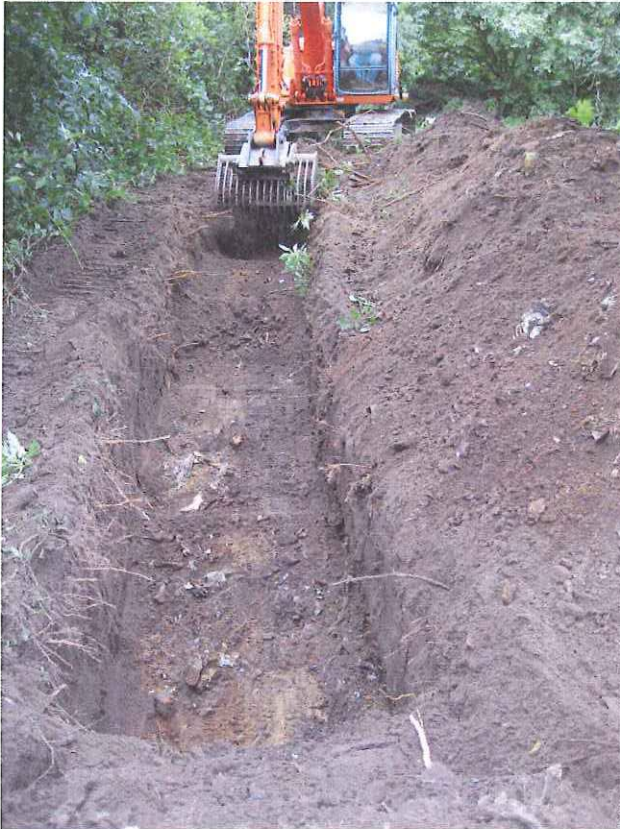
Fotonummer: 05 Omschrijving: Sleuf 1, bovenkant stort in de lengterichting
