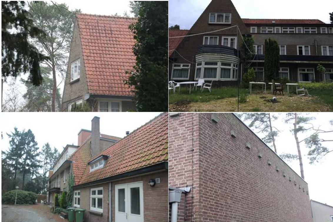
Impressie van de te slopen bebouwing in het plangebied.
