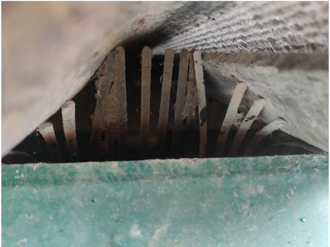
Een deel van de golfplatendaken is voorzien van vogelschroot
