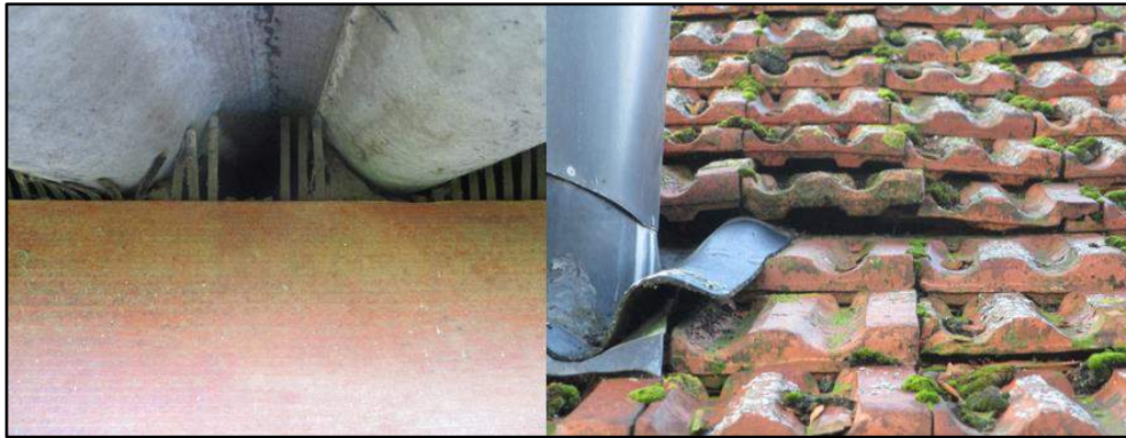
Figuur 4 Kapotte vogelschoot en enkele losliggende dakpannen
