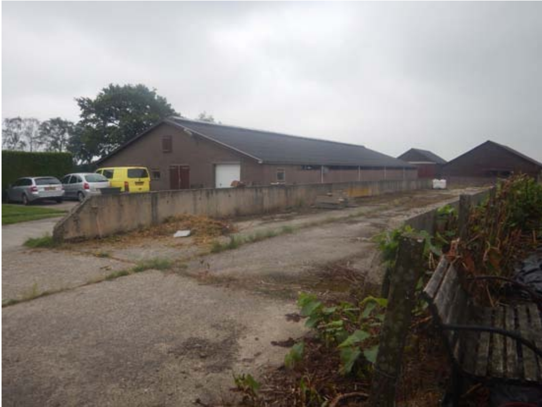
Figuur 13: Foto van de noordwestelijke schuur en sleufsilos, gezien vanuit het zuiden.
