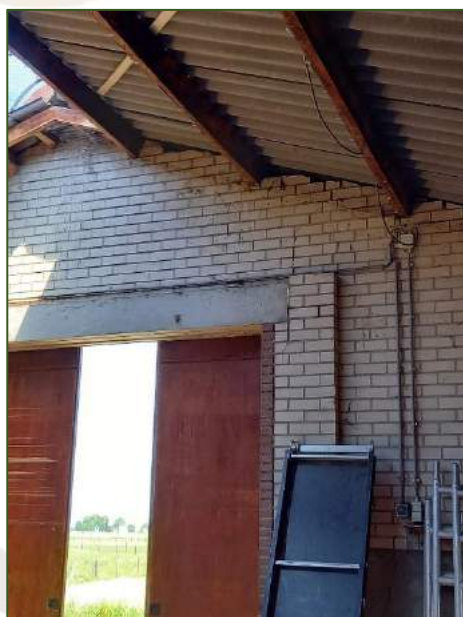
Fig. 2.4 Binnenzijde schuur 1 (bron: FF Solutions)
