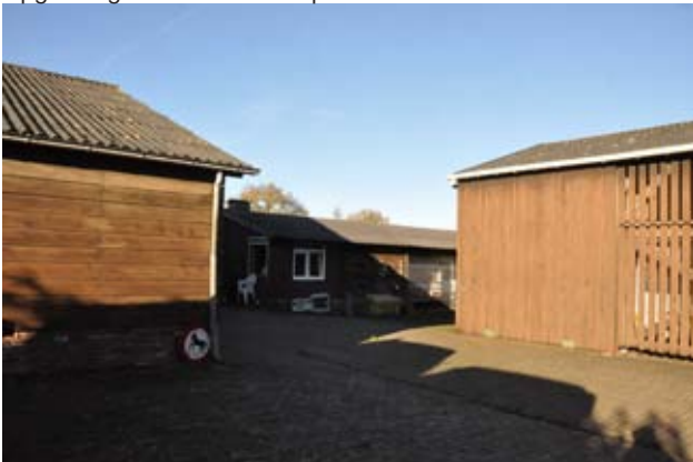
Ensemble van te slopen gebouwen achter nr 99
