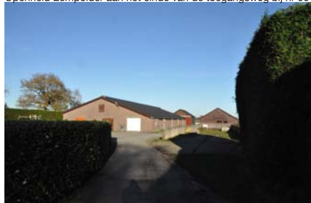
Ensemble van te slopen gebouwen achter nr 97a
