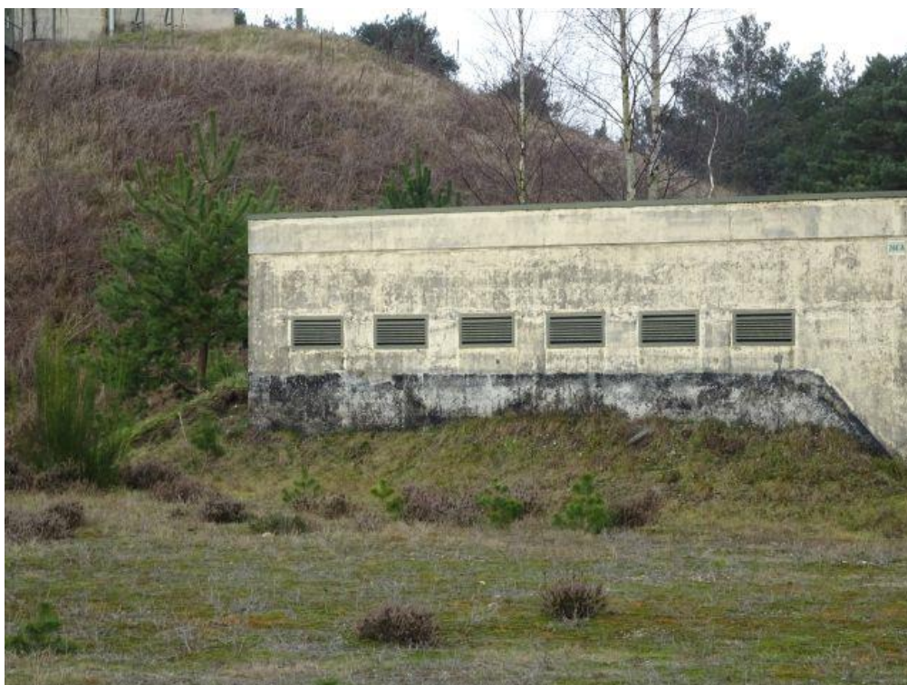
Detail betonnen gebouw bij kerosineheuvel.
